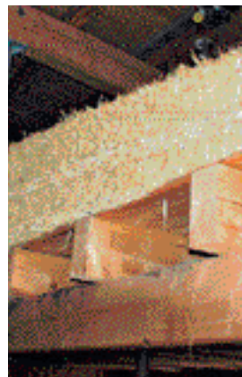
Das Kurzstroh wird über Rohre deponiert. In diesem Fall wird es um die beiden Abwurfenster gelagert. Beim Zerkleinerungsvorgang wird über einen Schlauch Wasser zugefügt, so dass kaum Staub aufwir-
